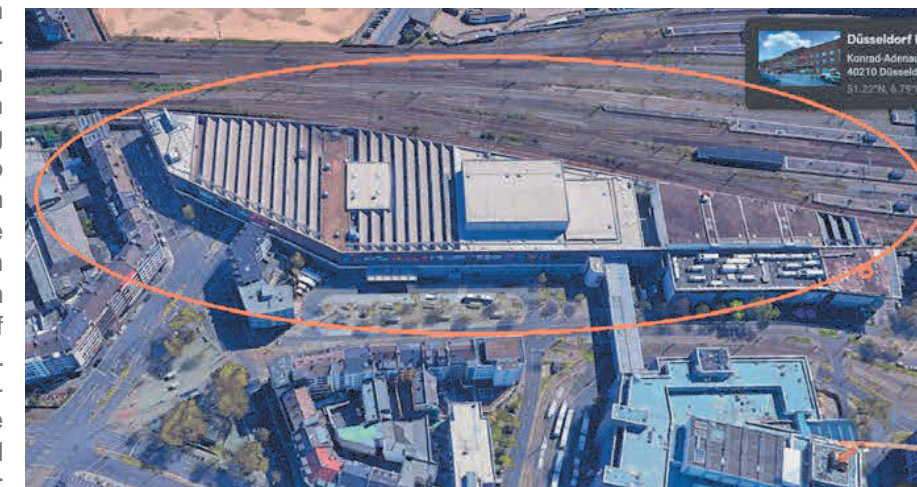
// Das in den 60ern eingeschobene Paketabfertigungsgebäude ist ein Keil, der den Worringer Platz die Sicht in die Kölner Straße nimmt und gleichzeitig eine Ausgestaltung des Busbahnhofs verhindert. Foto: Stadt Düsseldorf, Katasteramt.
